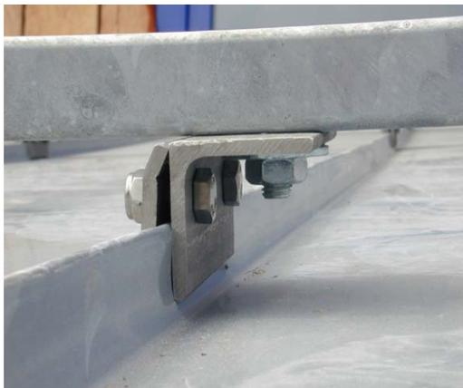
Montage sur toit en tôle avec joint vertical
