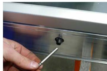
ill 1: Montage sonde de capteur
