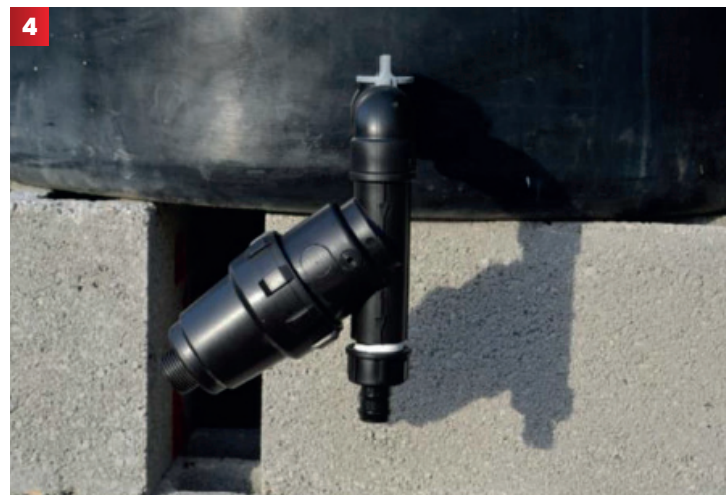
4 Fixez l'adaptateur cannelé 20 mm x 3/4" F au filtre
