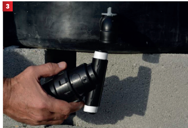
3 Assemblez le filtre 3/4" avec le coude. Suivez le sens de la flèche sur le filtre
