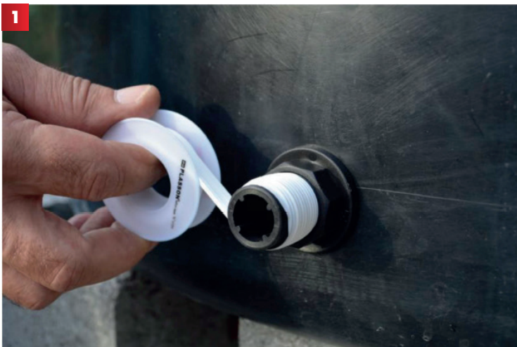
1 Recouvrez le filetage de téflon dans le sens des aiguilles d'une montre
