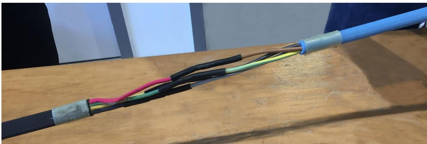
4/ Protéger l'ensemble avec la grosse gaine thermo-rétractable, chauffer en commençant par le centre puis se décaler vers les extérieurs pour éviter les bulles d'air.
