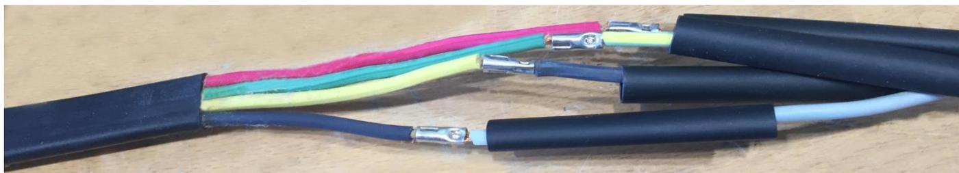
2/ Protéger les connexions avec les gaines thermo-rétractables à l'aide d'un décapeur thermique.
