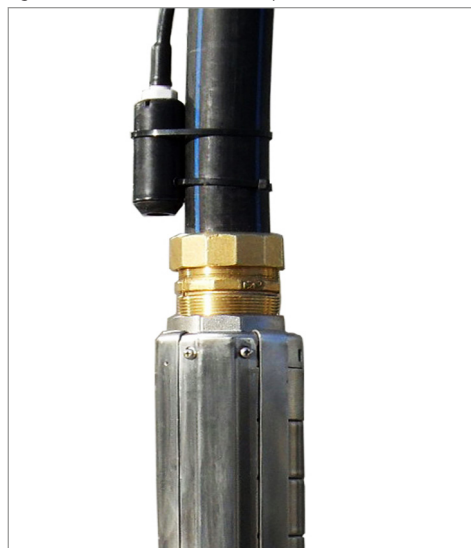
Figure 21: fixation de la sonde de puits
