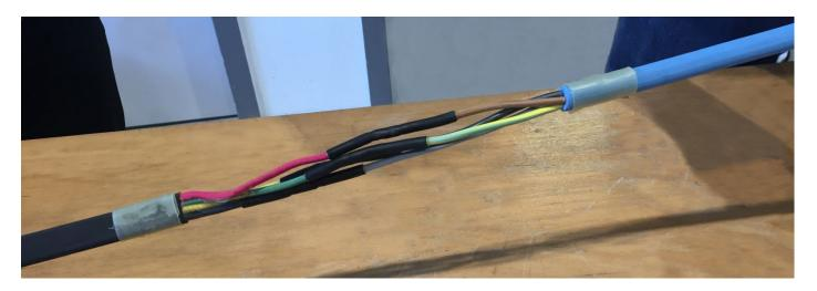
4/ Protéger l'ensemble avec la grosse gaine thermo-rétractable, chauffer en commençant par le centre puis se décaler vers les extérieurs pour éviter les bulles d'air.
